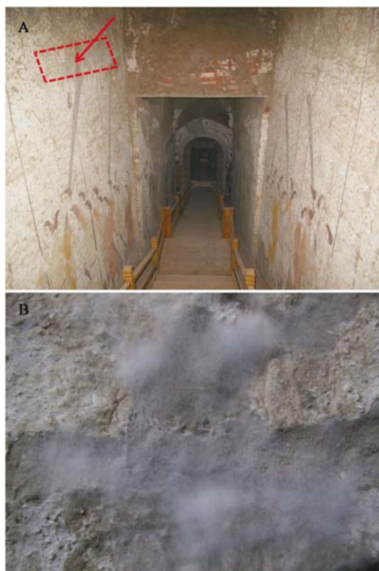
图 1 墓道西壁主要霉变区域(A, 箭头所示虚线框内)及壁画表面白色霉变物(B)
